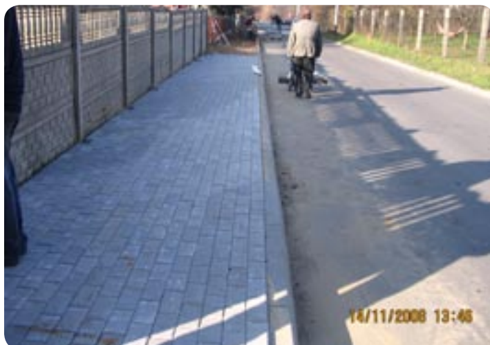
▼ Budowa chodników przy ulicy Ogrodowej
