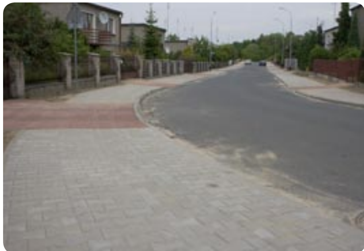
▼ Budowa chodników w ulicy Grzybowej
