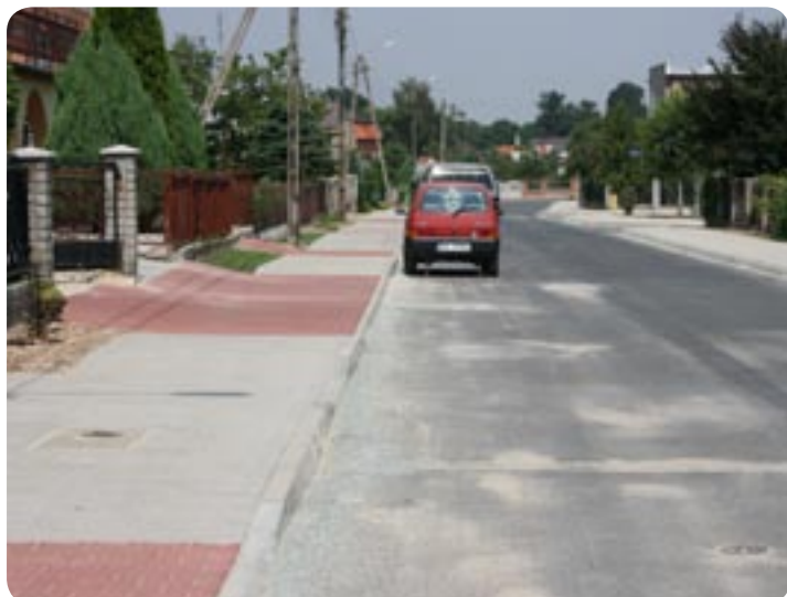
▼ Budowa chodników w ulicy H. Wiernego
