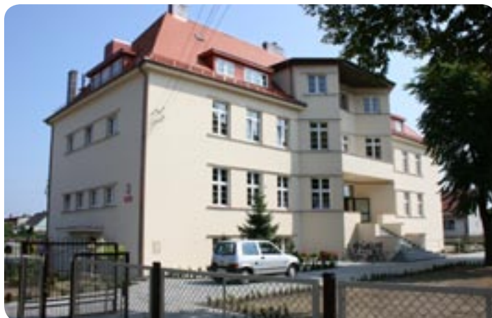
▼ Remont budynku Przedszkola Miejskiego
