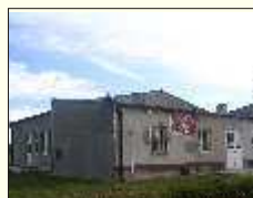
Okna i drzwi już wymienione
