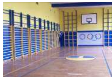
Parkiet sali gimnastycznej (po renowacji) Szkoły Podstawowej nr 1 w Twardogórze
