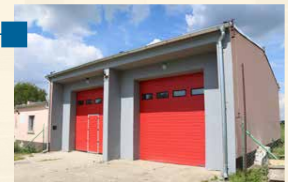
Remont dachu budynku OSP w Grabownie Wielkim wartość: 47 970,00 zł
