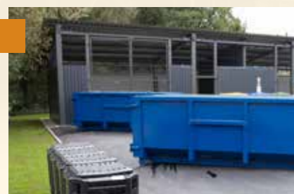
wiaty do gromadzenia odpadów, remont budynku garażowo-magazynowego, punkt przyjmowania rzeczy używanych, punkt napraw
