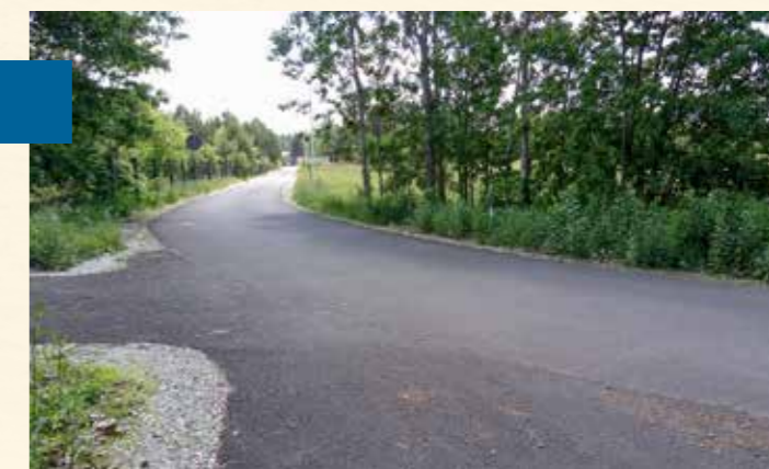
Przebudowa drogi gminnej nr 120304D w Sosnowce wartość: 634 067,66 zł dofinansowanie: 352 761,00 zł
