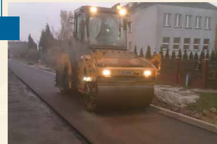
Remont nawierzchni drogi w Łazisku - etap 2 dotacja Gminy Twardogóra: 180 000,00 zł Porozumienie z Powiatem Oleśnickim
