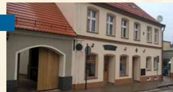
Remont budynków przy ul. Ratuszowej 2 i Placu Piastów 15 wartość: 524 939,29 zł dotacja Gminy Twardogóra: 98 505,80 zł środkami ZGM
