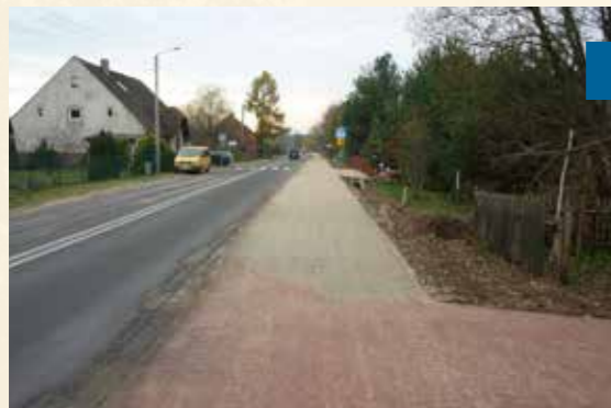
Budowa ścieżki pieszo-rowerowej w Sosnówce wartość: 312 688,56 zł
