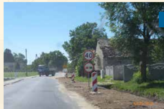
Budowa kanalizacji w Grabowni Małym - etap 1a wartość: 3 382 500,00 zł dofinansowanie: 1 999 374,00 zł
