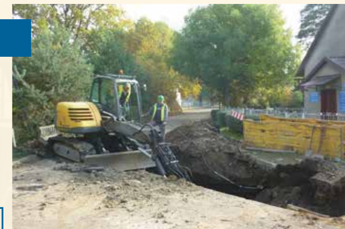
Budowa przyłączy kanalizacyjnych w aglomeracji Twardogóra wartość: 778 467,00 zł dofinansowanie: 270 000,00 zł
