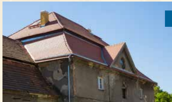
Remont dachu budynku nr 7 w zespole pałacowo-parkowym w Goszczu wartość: 378 815,42 zł dofinansowanie: 108 807,64 zł
