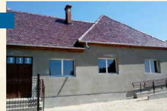
Rozbudowa budynku świetlicy wiejskiej o budynek toalet wraz z zagospodarowaniem terenu w Nowej Wsi Goszczańskiej wartość: 228 320,83 zł
