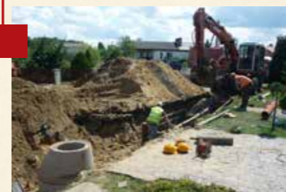
budowa przyłączy kanalizacyjnych
