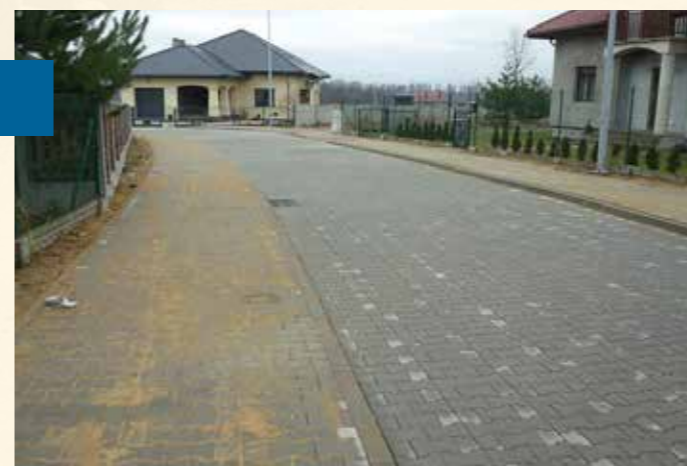
Budowa chodników pomiędzy ulicami Topolową i Bukową, Bukową i Kasztanową, Akacją i Wierzbową wraz z oświetleniem wartość: 126 936,30 zł
