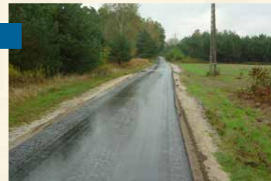
Wykonanie nawierzchni bitumicznej - Pajęczak wartość: 95 203,20 zł
