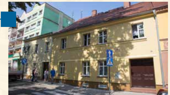
Remont budynków przy Placu Piastów 13 i 14 wartość: 109 899,00 zł środkami ZGM
