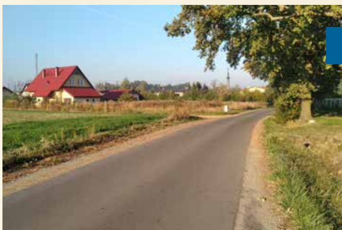
Przebudowa drogi gminnej nr 120294 D w Moszycach wartość: 59 999,40 zł
