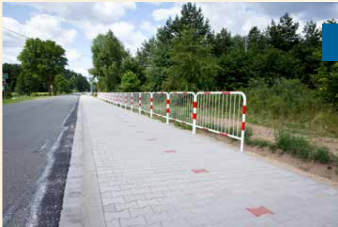
Budowa ścieżki pieszo-rowerowej w Drogoszowicach i na odcinku Drogoszowice-Sosnówka w ramach systemu ścieżek pieszo-rowerowych Gminy Twardogóra wartość: 451 094,70 zł dofinansowanie: 193 296,00 zł
