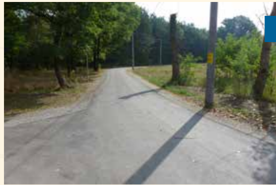
Budowa drogi gminnej w Goli Wielkiej wartość: 717 696,40 zł dofinansowanie: 427 950,00 zł
