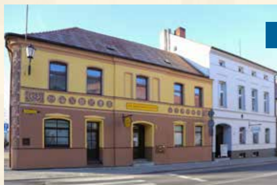
Remont budynku HPS ul. Ratuszowa 1a i 1b wartość: 412 528,77 zł dotacja Gminy Twardogóra: 299 860,59 zł
