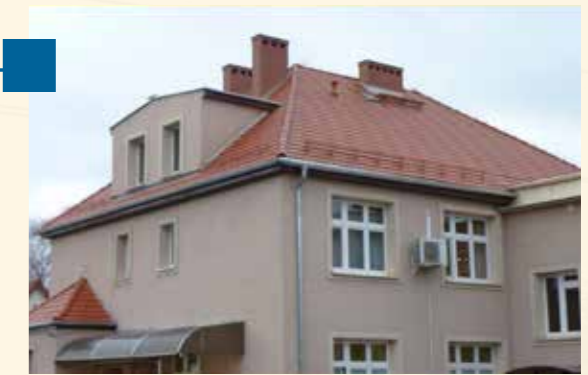
Przebudowa dachu budynku SZPZOZ w Twardogórze wartość: 113 844,41 zł
