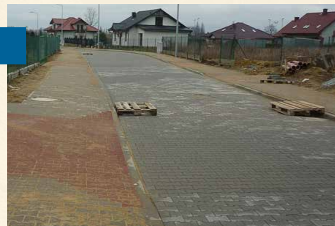
Budowa ulicy Bukowej, Kasztanowej i Wierzbowej wraz z infrastrukturą techniczną w Twardogórze wartość: 1 366 423,60 zł dofinansowanie: 679 119,00 zł
