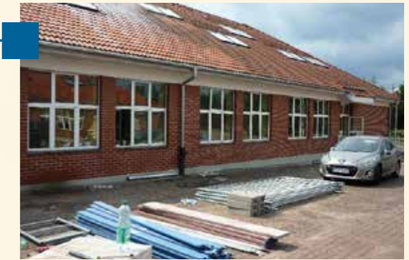
Przebudowa dachu w budynku Gimnazjum i SP nr 2 w Twardogórze wartość: 474 466,47 zł
