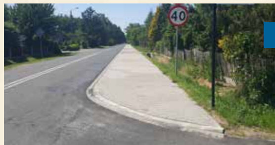
Budowa ścieżki pieszo-rowerowej w Sosnówce wartość: 250 000,00 zł dofinansowanie: 250 000,00 zł
