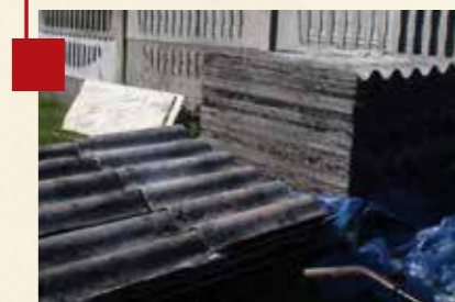
usuwanie wyrobów zawierających azbest
