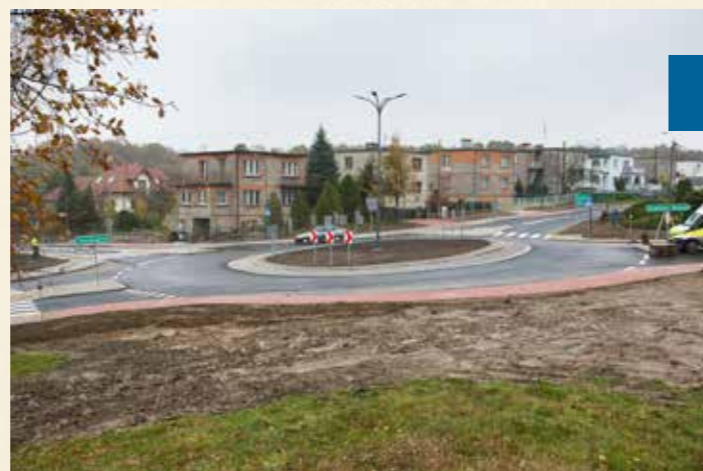
Rozbudowa drogi gminnej Sądrożyce-Dąbrowa wraz z przebudową skrzyżowań z drogami po- wiatowymi nr 1470D i 1480D wartość: 6 110 754,61 zł dofinansowanie: 2 884 802,75 zł
