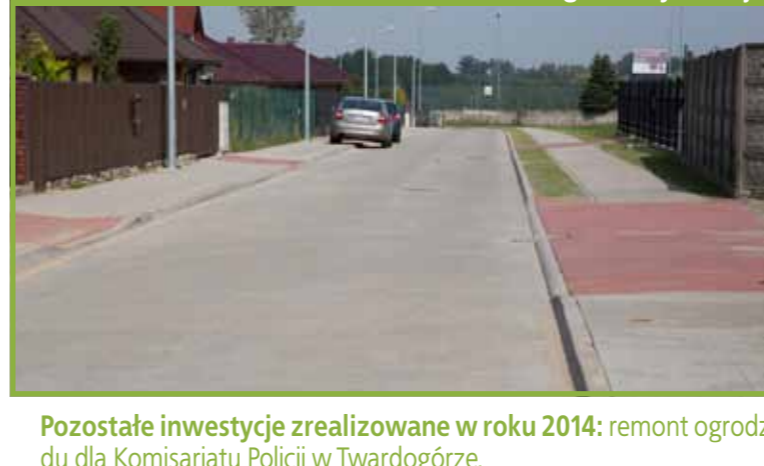
budowa drogi w ulicy Polnej
