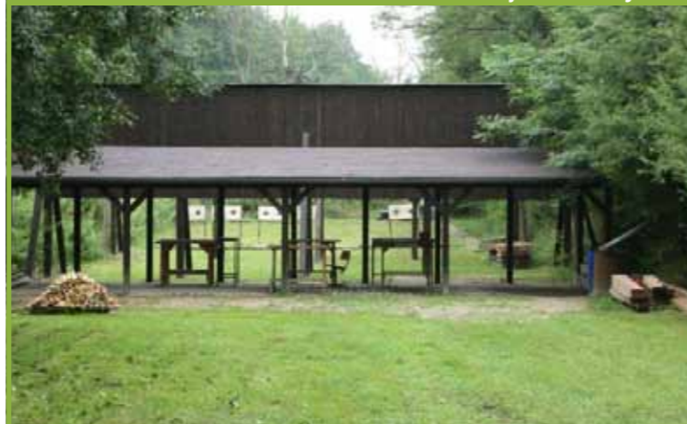
modernizacja strzelnicy LOK
