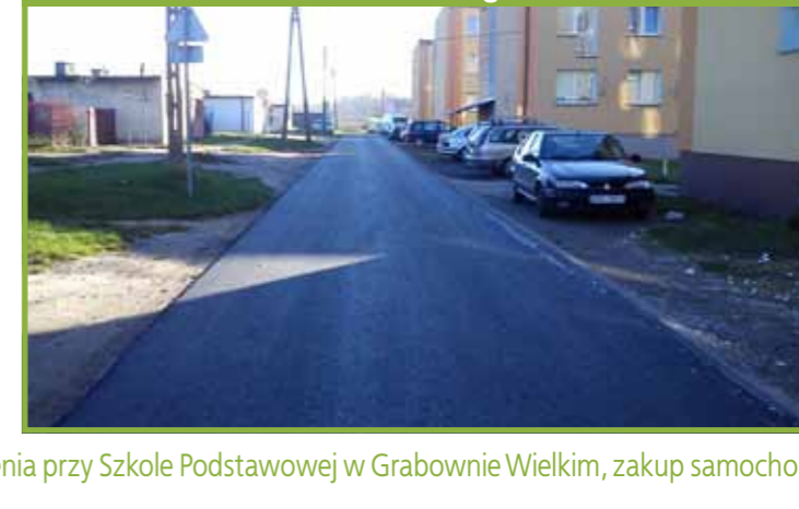
budowa drogi w Grabownie Wielkim
