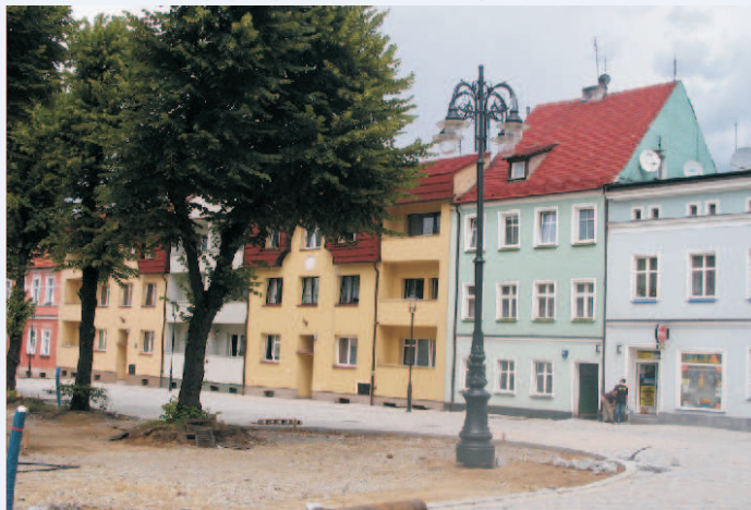
Przebudowa płyty Rynku w Twardogórze – etap II
