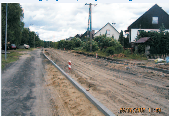
Budowa drogi przy ul. Dębowej w Twardogórze
