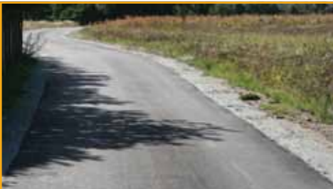
Nowa droga w Grabownie Wielkim
