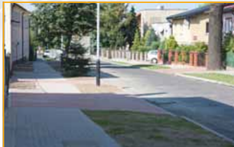
Ulica Lipowa z nowym chodnikiem
