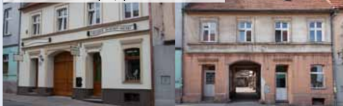
Ratuszowa 1c - po / przed remontem
