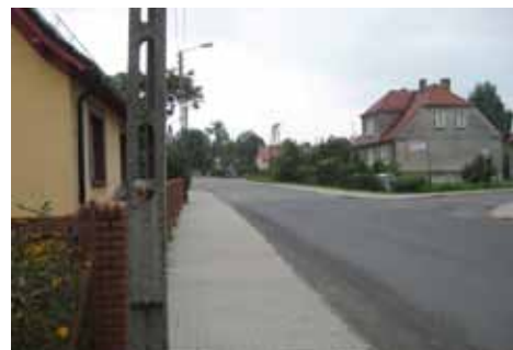
remont chodników przy ulicy Oleśnickiej
