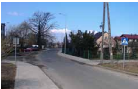
budowa chodnika i oświetlenia w Moszycach
