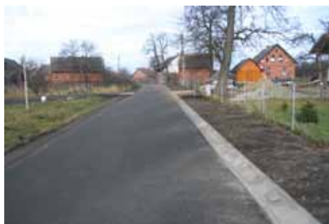
budowa drogi relacji Bukowinka - Białe Błoto
