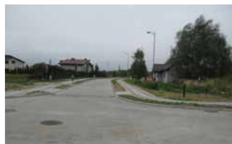
budowa dróg w ulicy Topolowej i Klonowej wraz z infrastrukturą techniczną
