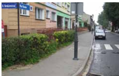
modernizacja chodników przy Placu Piastów i ulicy Powstańców
