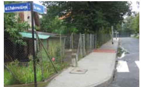
budowa chodnika w ul. Paderewskiego i pl. Kolejowym
