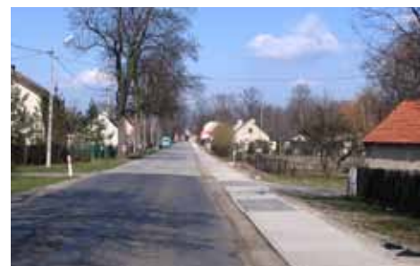
budowa chodników przy ulicy Twardogórskiej w Goszczu
