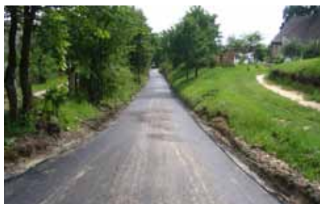
modernizacja drogi gminnej w Chelstowie
