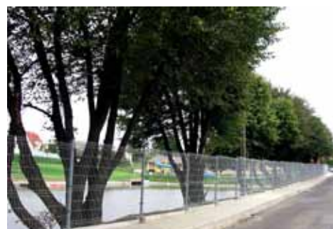
wymiana ogrodzenia wokół basenu
