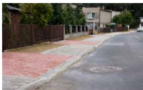
budowa chodników w ul. Grzybowej, Malinowej, Borówkowej, Jagodowej w Twardogórze
