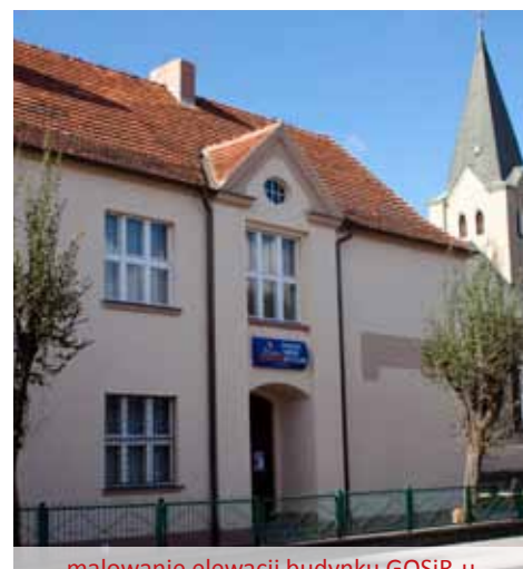
malowanie elewacji budynku GOSiR-u przy ulicy 1-go Maja w Twardogórze
