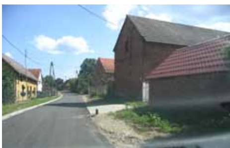
modernizacja drogi gminnej w Grabownie Małym
