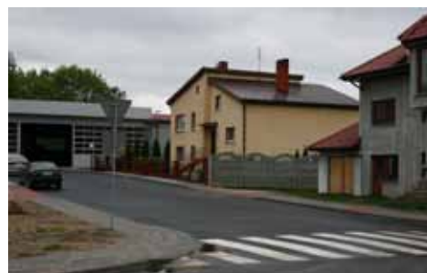
remont ulicy Kruczej
