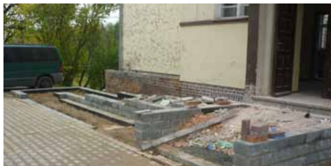
Podjazd przy świetlicy w Chełstowie
