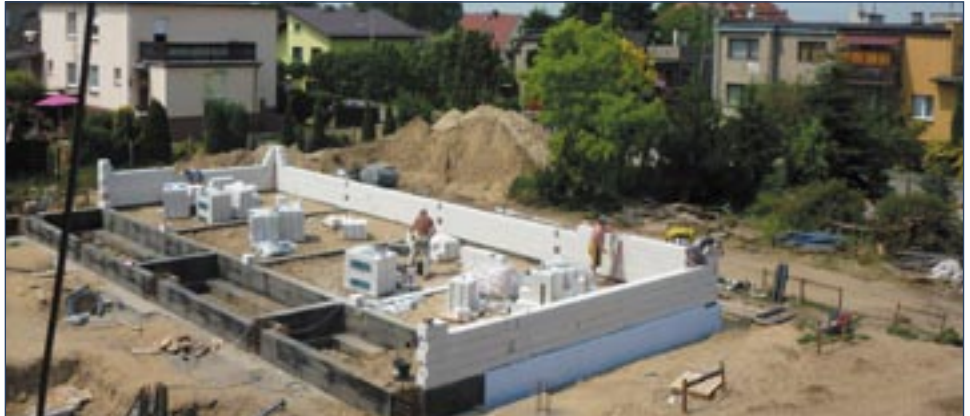
Widać już zarys sali gimnastycznej przy SP 1. Konsorcjum „Michalski” z Leszna zakończyło prace ziemne, wykonało przyłącza sanitarne oraz fundamenty. Rozpoczęto budowę ścian. Koszt inwestycji to 3 578 435,95 zł. Zakończenie budowy przewidziane jest do marca przyszłego roku.
