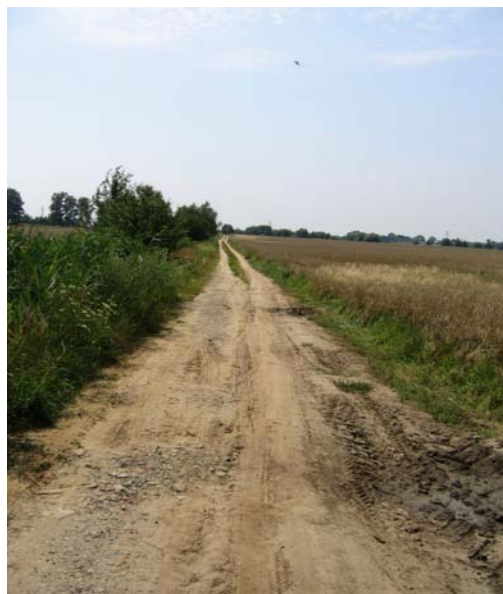
Fot. nr 49. Droga gruntowa w obrębie Nowa Wieś Goszczańska przewidziana do modernizacji.
