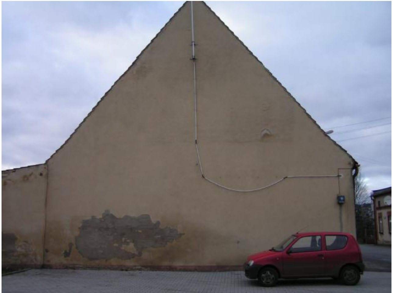
Zdjęcie nr 4 – elewacja południowo-zachodnia
