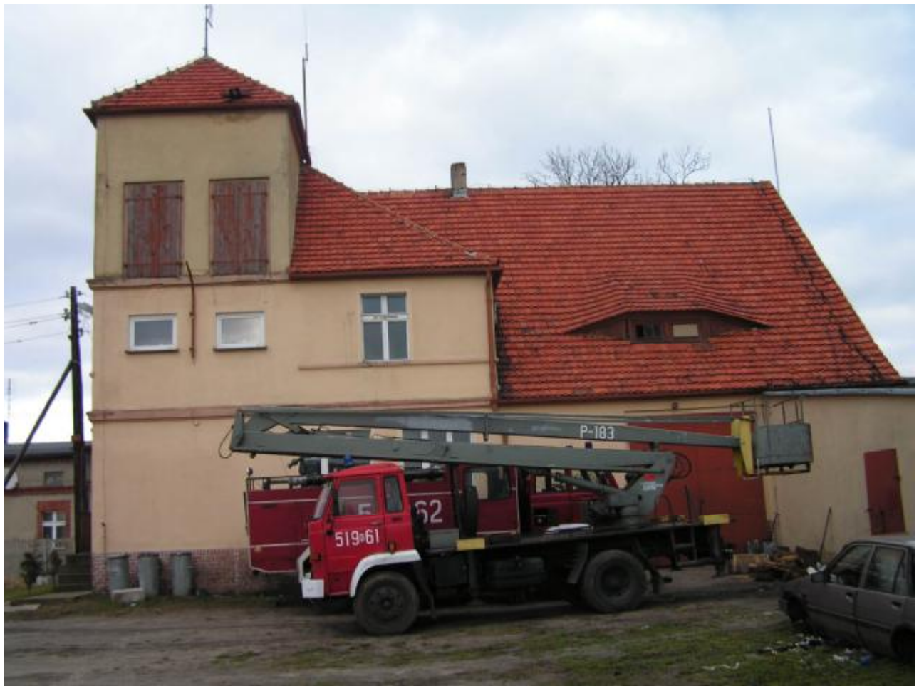
Zdjęcie nr 3 – elewacja północno-zachodnia
